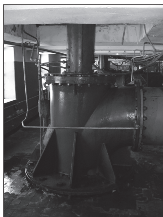
Rys. 3. Układ wylotowy pompy
